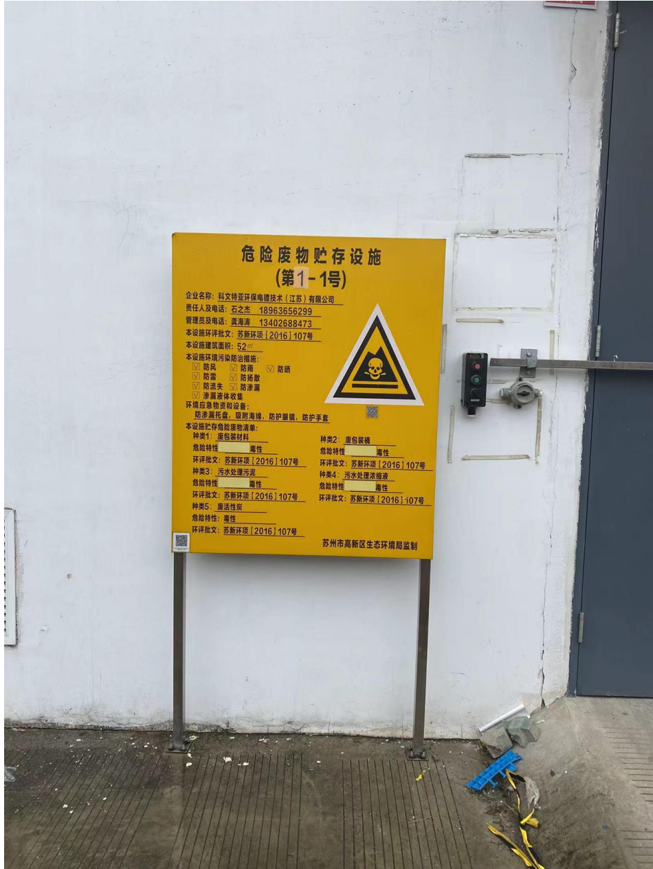
图 4-1 危废仓库外部照片
