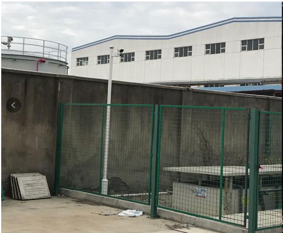
图 4-3 危废仓库内外部摄像头
